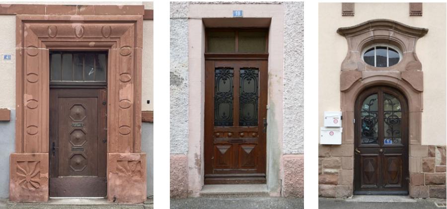
Portes de la fin du 19e siècle et du début du 20e siècle [B] avec une imposte vitrée et des grilles en fer ou fonte ouvragées.
