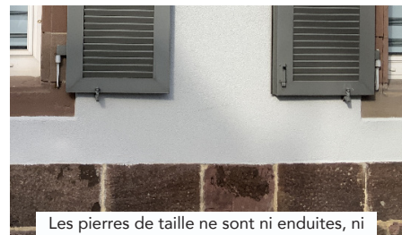
Les pierres de taille ne sont ni enduites, ni peintes. Elles sont liées au mortier de chaux pour assurer l'évacuation de l'humidité.
