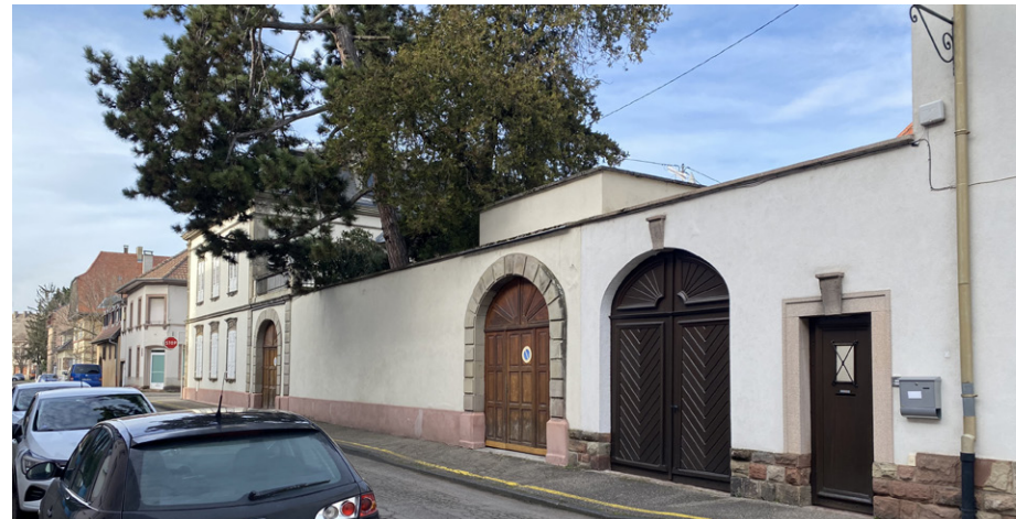
La clôture de Neuf-Brisach participe aux alignements de la trame de Vauban
