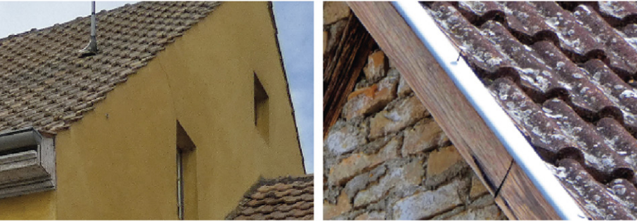
La finition traditionnelle de la rive du toit est réalisée au mortier ou à l'aide d'une planche sobre, sans décor.
