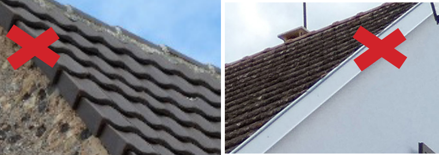
Les rives en tuiles à rabat ou en tôle banalisent l'architecture traditionnelle.
