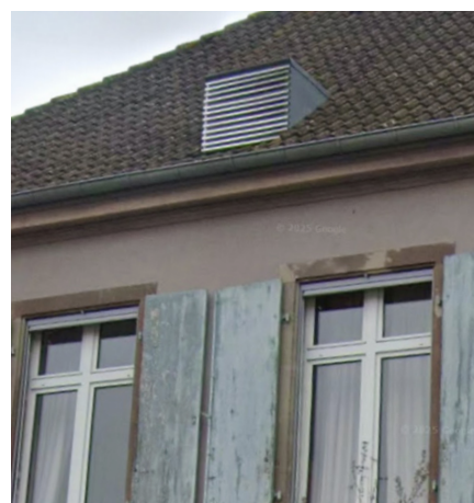
En excroissance du toit, recréant un volume proche d'une nouvelle lucarne. On privilégiera l'intégration dans une lucarne si elle existe.
