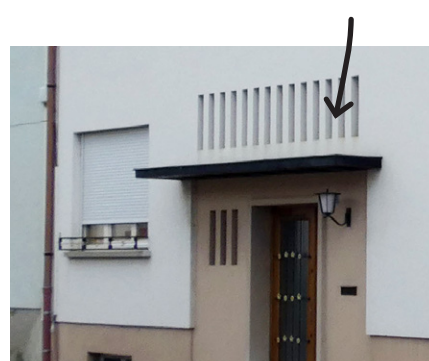
Dans un caisson en faux plafond au dessus de l'entrée. Les ouvertures contribuent à la composition de la façade.
