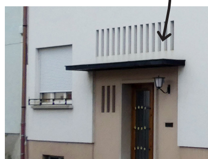
Dans un caisson en faux plafond au dessus de l'entrée. Les ouvertures contribuent à la composition de la façade.
