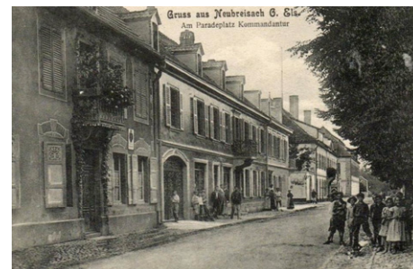
Pavages en galets en pieds de façade et terre stabilisée pour la chaussée
