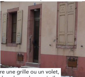
Derrière une grille ou un volet, dans le volume du soupirail
