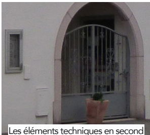
Les éléments techniques en second plan dans le renforcement
