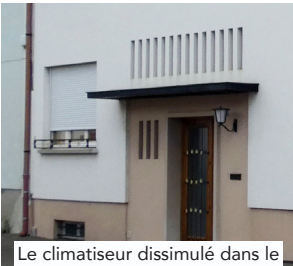
Le climatiseur dissimulé dans le plenum de l'entrée
