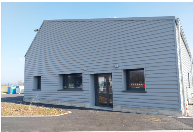
Nouveaux bureaux du service PGD
