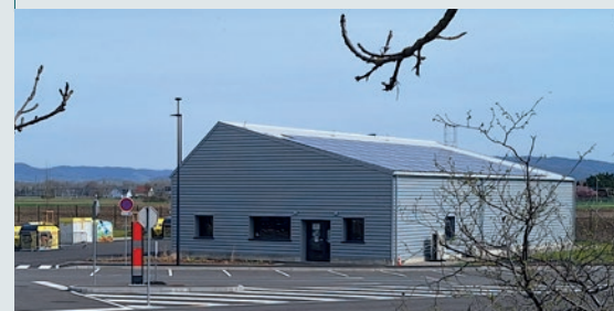
La centrale photovoltaïque sur la toiture des locaux du service Prévention et Gestion des déchets
