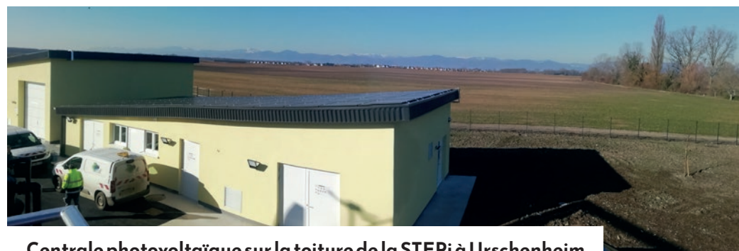
Centrale photovoltaïque sur la toiture de la STEPi à Urschenheim
